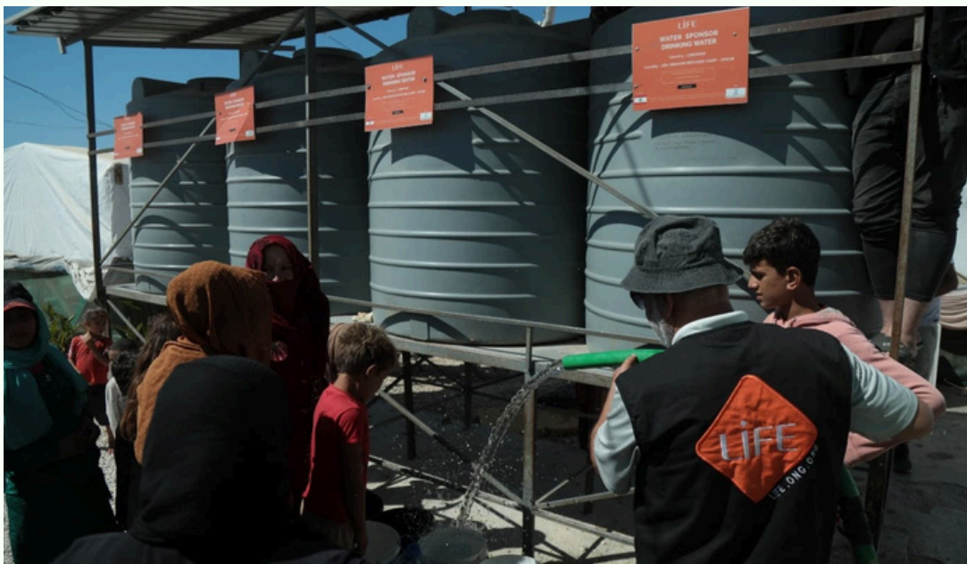
Installation de citernes d'eau potable par notre ONG LIFE dans le camp de réfugiés d'Abu Ibrahim, Liban, 2024.
